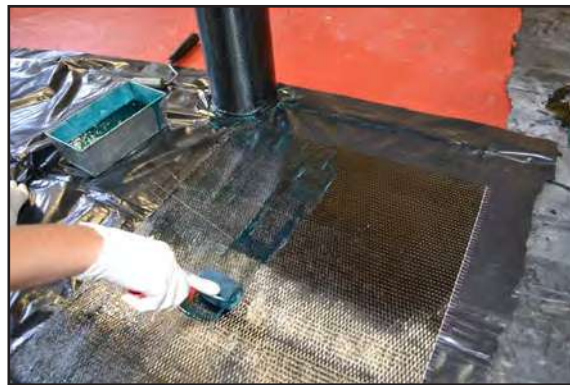
FIGURA 10 - Aplicação da fibra.
