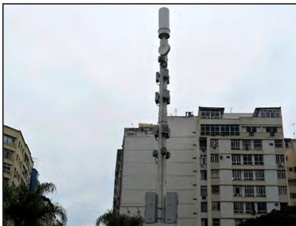
FIGURA 13 - Antena temporária na Praça Demétrio Ribeiro
