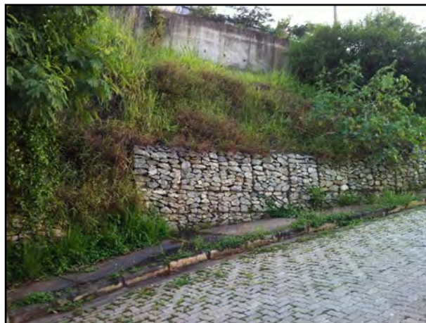
FIGURA 1 - Muro de gabião caixa
