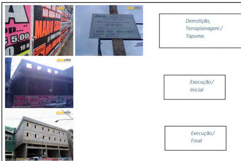
FIGURA 10 - Fotos da etapa de execução da obra.
