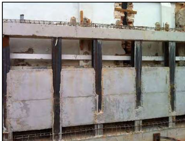
FIGURA 8 - Estacas tipo perfis metálicos
