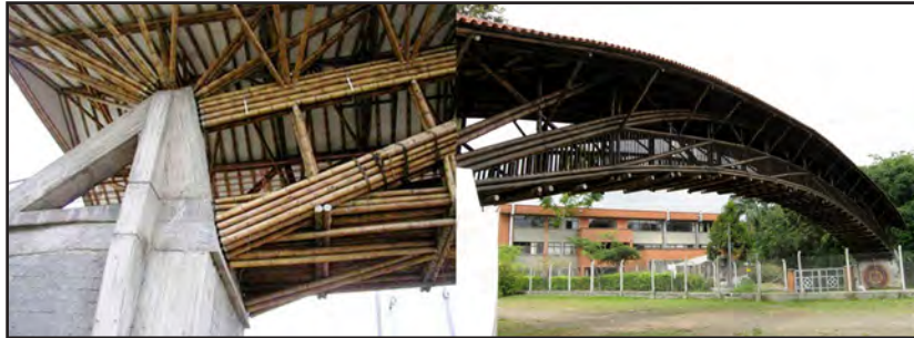
FIGURA 13 - Passarela de bambu em Santo Antônio/Colômbia
