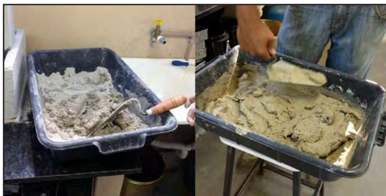
FIGURA 5 - Preparação da argamassa com traço 1 : 0,5 : 4,5
