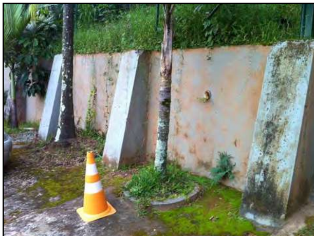
FIGURA 5 - Muro de contrafortes
