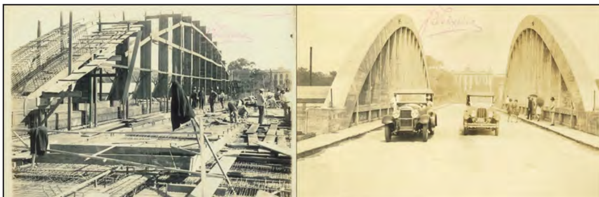
FIGURA 2 - Fotos históricas da construção e uso do Viaduto Santa Teresa.
