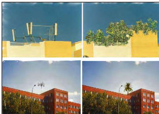
FIGURAS 11 e 12 - Exemplos de camuflagens de rooftops que imitam uma vegetação
