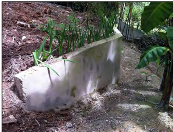
FIGURA 4 - Muro de flexão
