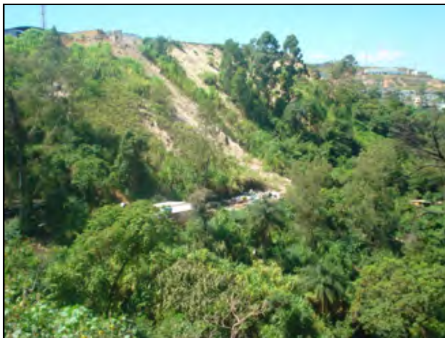
FIGURA 3 - Movimentação irregular de terra no Distrito Industrial Jardim Piemonte
