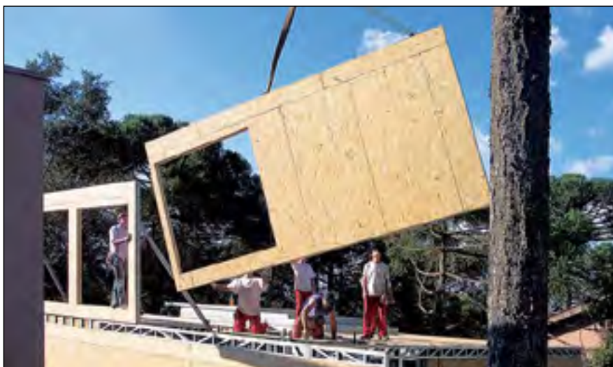
FIGURA 19 - Painéis de OSB na estrutura
