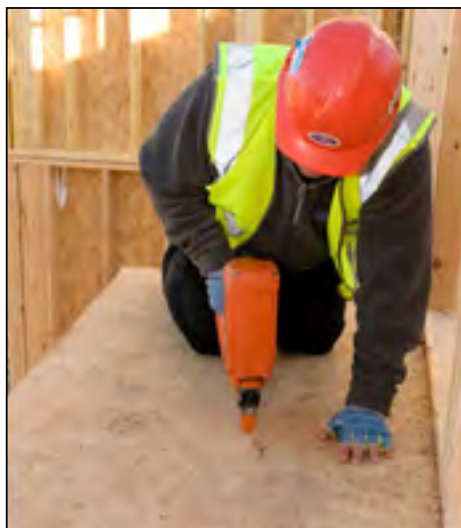
FIGURA 5 - Fixação de um painel
