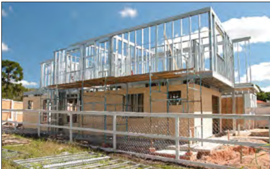
FIGURA 18 - Construção em Steel Frame
