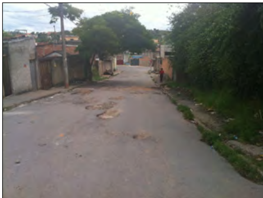
FOTO 04 - Pavimentação bairro Morro Alto.
