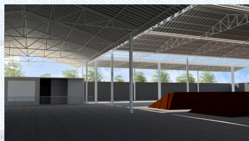
Interior da usina de compostagem, com iluminação zenital.
