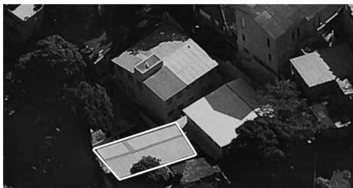
Figura 2 – Foco no local específico para a implantação do projeto. Telhado da quadra, área utilizada para a coleta da água.
