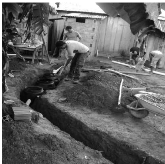
FIGURA 2 – Implantação dos tanques em Curionópolis, no Pará. Fonte: Bressani e Daniel Pires (2011).
