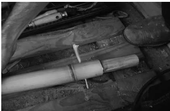
FIGURA 4 – Tarugo de madeira introduzido na parte interna do bambu. Fonte: Negrão Fotografia, nov. 2007.
