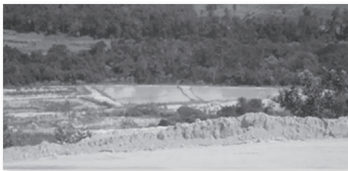
FIGURA 1 - Vista geral dos tanques de decantação
