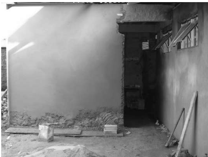
Figura 5 – Foto da execução da obra Autora: Júlia Peluzzo
