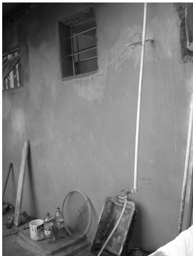
Figura 6 – Foto da execução da obra Autora: Júlia Peluzzo
