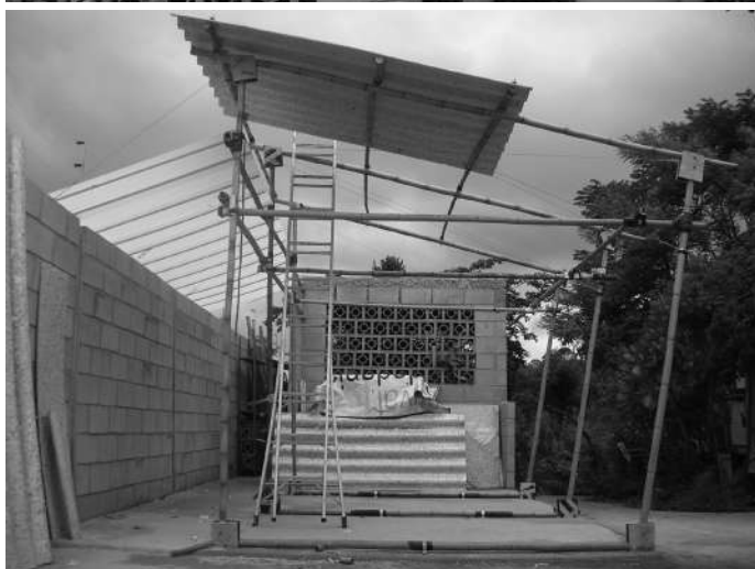
Figura 7 – Pequena edificação onde foram utilizados os conectores
